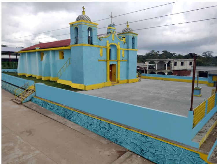
Iglesia terminada de construir en 1934, edificio más antiguo de la comunidad
